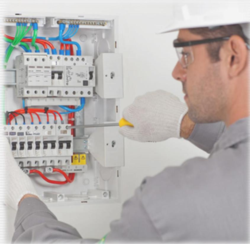
Para **garantir uma instalação elétrica segura** e dentro das diretrizes da NBR5410, é necessária a utilização de dispositivos de segurança para a proteção dos circuitos da residência, **tanto contra choques quanto sobreaquecimento ou surtos de corrente ou tensão.**
